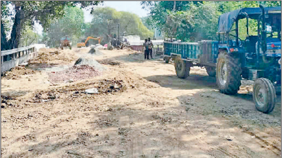
कनीना। स्टेट हाइवे पर उन्हाणी के समीप बनाया जा रहा नहरी पुल।
